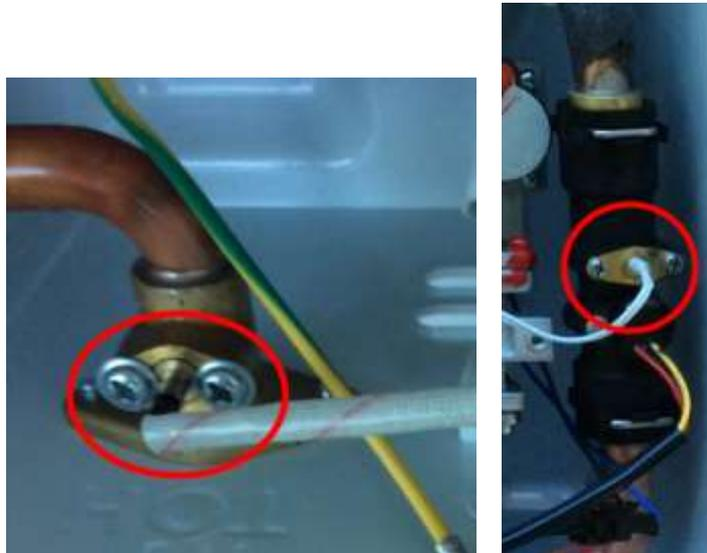
Figura 10 – Sensores de temperatura de salida /entrada
