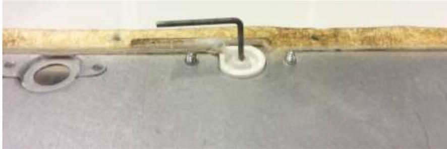
Figura 15 – Electrodo de ionización
