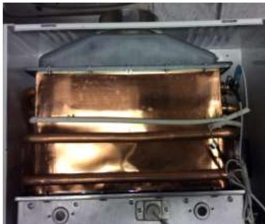
Figura 16 – Permutador de calor
