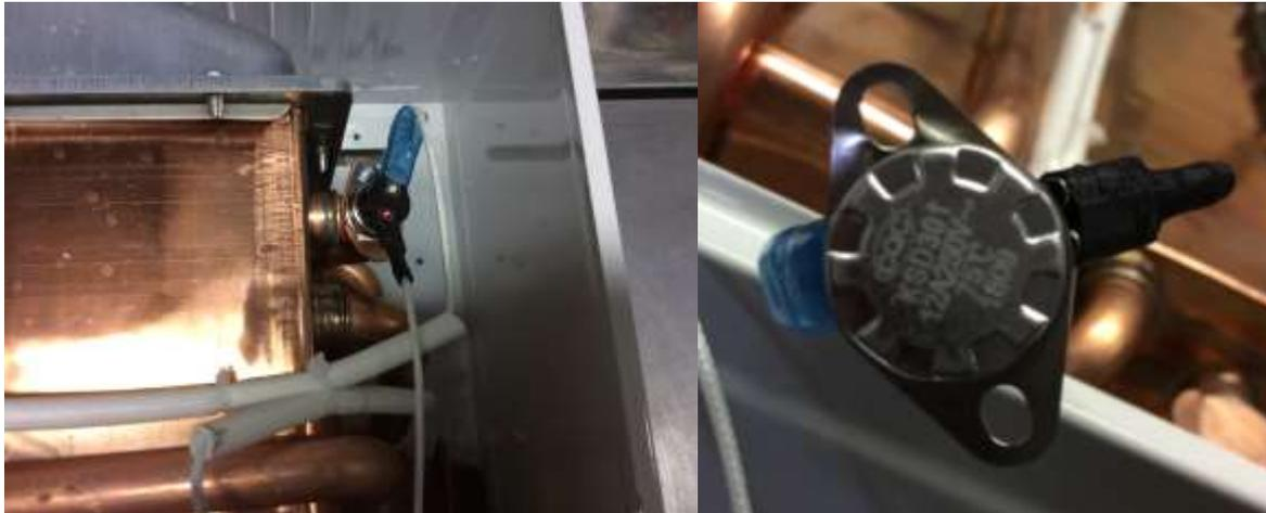
Figura 17 – Ejemplo de limitador de temperatura
